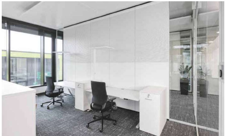
/ Freundlicher Empfang: Offen und großzügig gibt sich die viergeschossige Empfangshalle mit Oberlichtverglasung im neuen Verwaltungsbau der AOK Bezirksdirektion Hochrhein-Bodensee in Waldshut. Die Bürozwischenwände aus der Vollwand Fecowand sind mit ihrer horizontalen Schlitzung akustisch wirksam.
