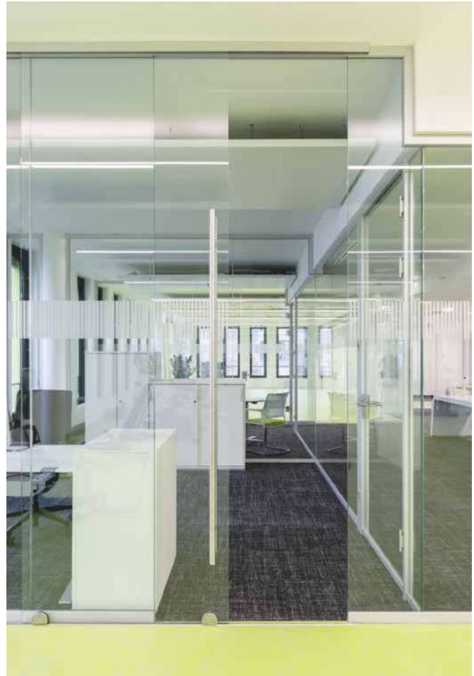
/ Optische wie physische Zonierung: Die Beraterbüros sind von den Verkehrsflächen durch die bodengeführten Glas-Schiebetüren ST10B transparent abgetrennt.
