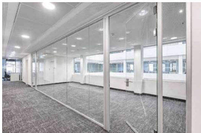
/ Licht und hell: Alle Flurwände und Türen des neuen Verwaltungsbaus der AOK Hochrhein-Bodensee in Waldshut sind verglast ausgeführt.
