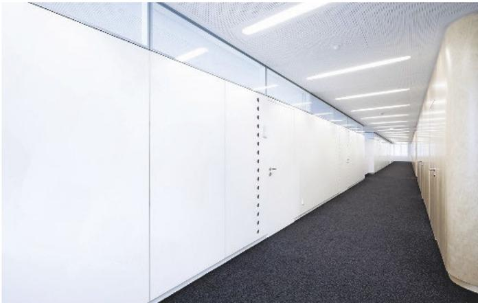
*/ Durchgängig flächenbündig: Das Glasband löst die nicht tragenden Bürotrennwände optisch von der betonkerntemperierten Stahlbetondecke.*
