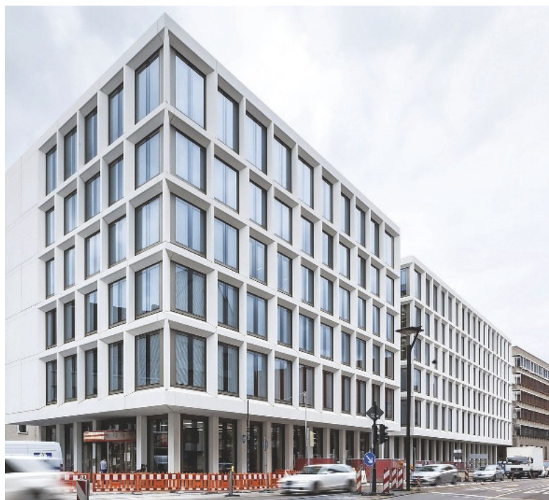
Durch die konische Drehung der Fassadenstützen und deren Wechsel in horizontaler und vertikaler Richtung erscheint die Fassade (Planung Nething) dynamisch.
