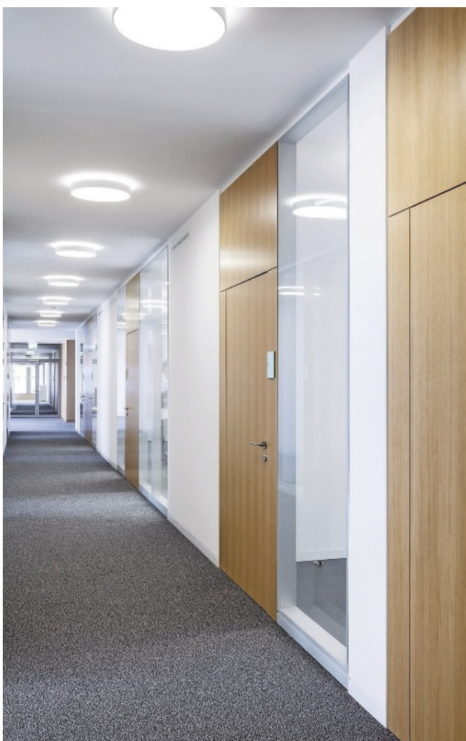
Die Tür- und fecostruct-Glaselemente sind flächenbündig in die Gipskartonwände eingesetzt (Haus 66, Nething Generalplaner).
