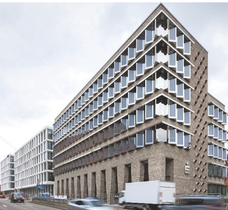
Die Fassade des von LRO geplanten Gebäudes Haus West besteht aus recycelten Ziegeln und Edelstahlrahmen für die Fensterbänder. Bilder: Nikolay Kazakov, Karlsruhe www.kazakov.de
