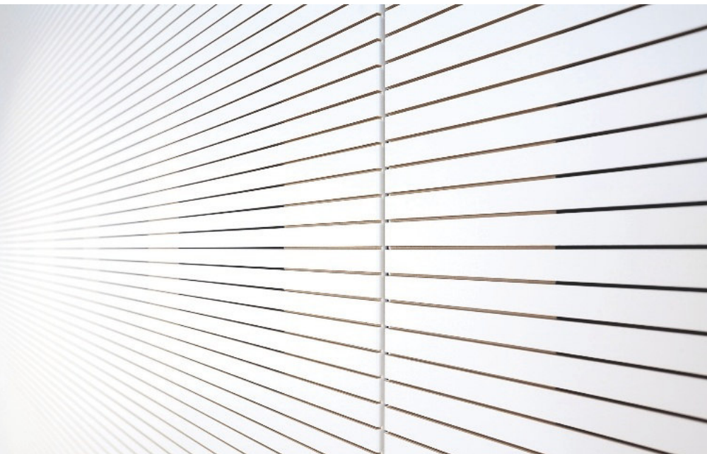
Die Flurwände sind raumseitig mit fecophon Akustikelementen zur Schallabsorption belegt (Haus West, Entwurf LRO).
